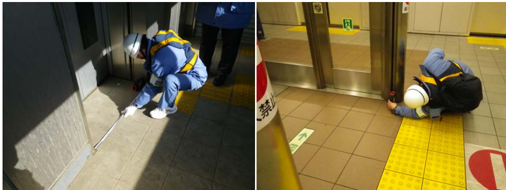
図 4-3-7 巻き尺や簡易レーザ計測機による簡便な計測の例
