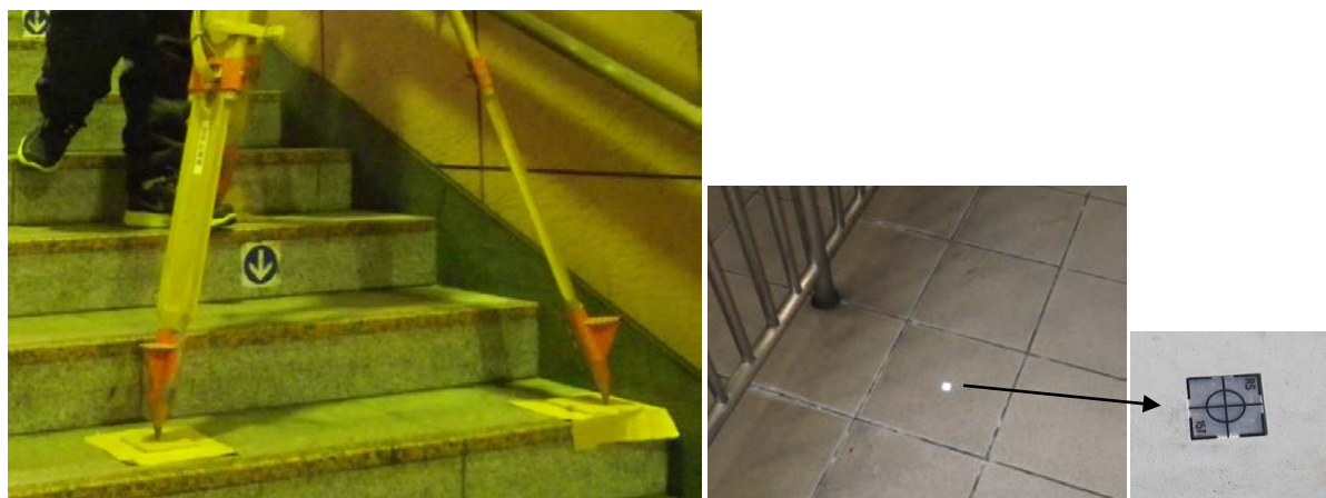
図 4-1-1 屋内（階段）における三脚設置と測量箇所を示すシールの例
