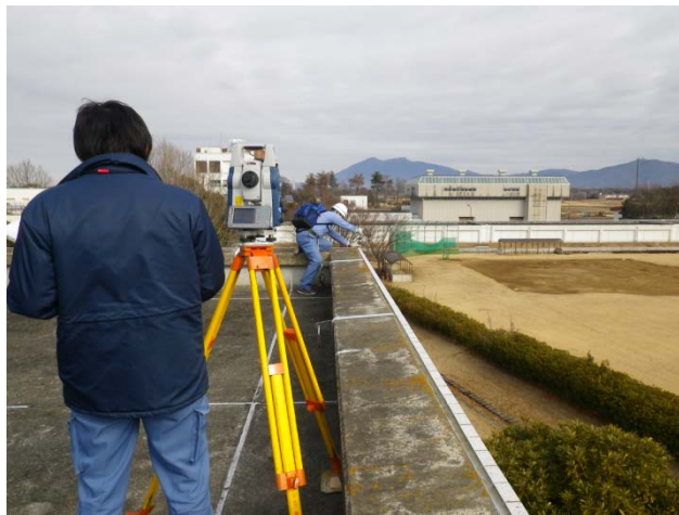
図 4-4-6 建物の四隅の現地測量の例
